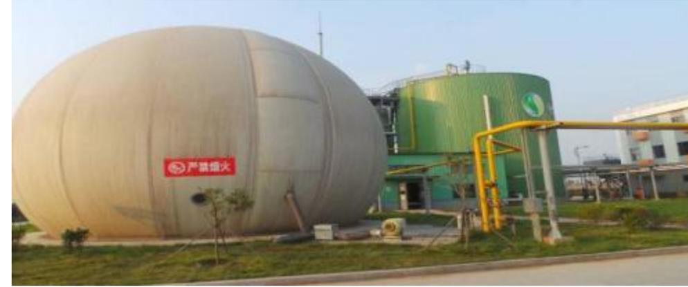
几乎每一座垃圾焚烧发电厂都有渗滤液处理厂，几乎每座渗滤液处理厂都有厌氧消化处理装置，我国的生活垃圾焚烧发电厂从某种意义上说也是有机垃圾厌氧消化处理厂
